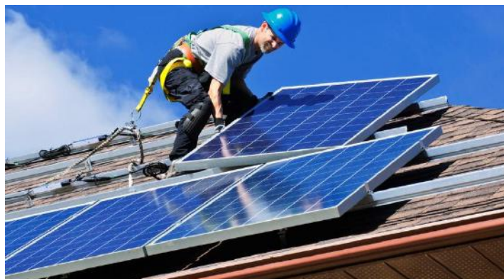
Gambar 7 Panel surya sedang dipasang di atap rumah [11].
