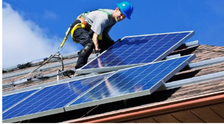
Gambar 7 Panel surya sedang dipasang di atap rumah [11].
